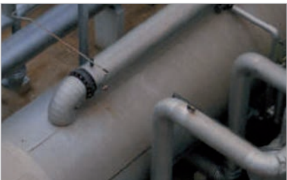
Lavaggi impianti di raffinazione
