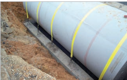
Lavaggi di serbatoi interrati
