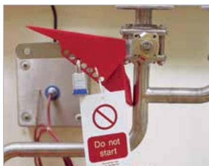
Il bloccaggio consente solo la posizione chiusa ad angolo retto per valvole con comando a leva. Da utilizzare assieme ad un lucchetto di chiusura.
