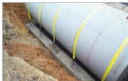
Lavaggi di serbatoi interrati
