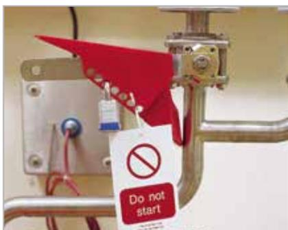
Il bloccaggio consente solo la posizione chiusa ad angolo retto per valvole con comando a leva.
