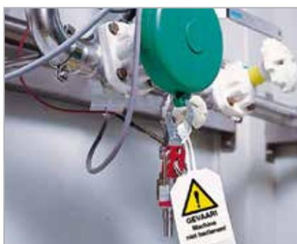
Un sistema sicuro e semplice di chiusura delle valvole a volantino.
