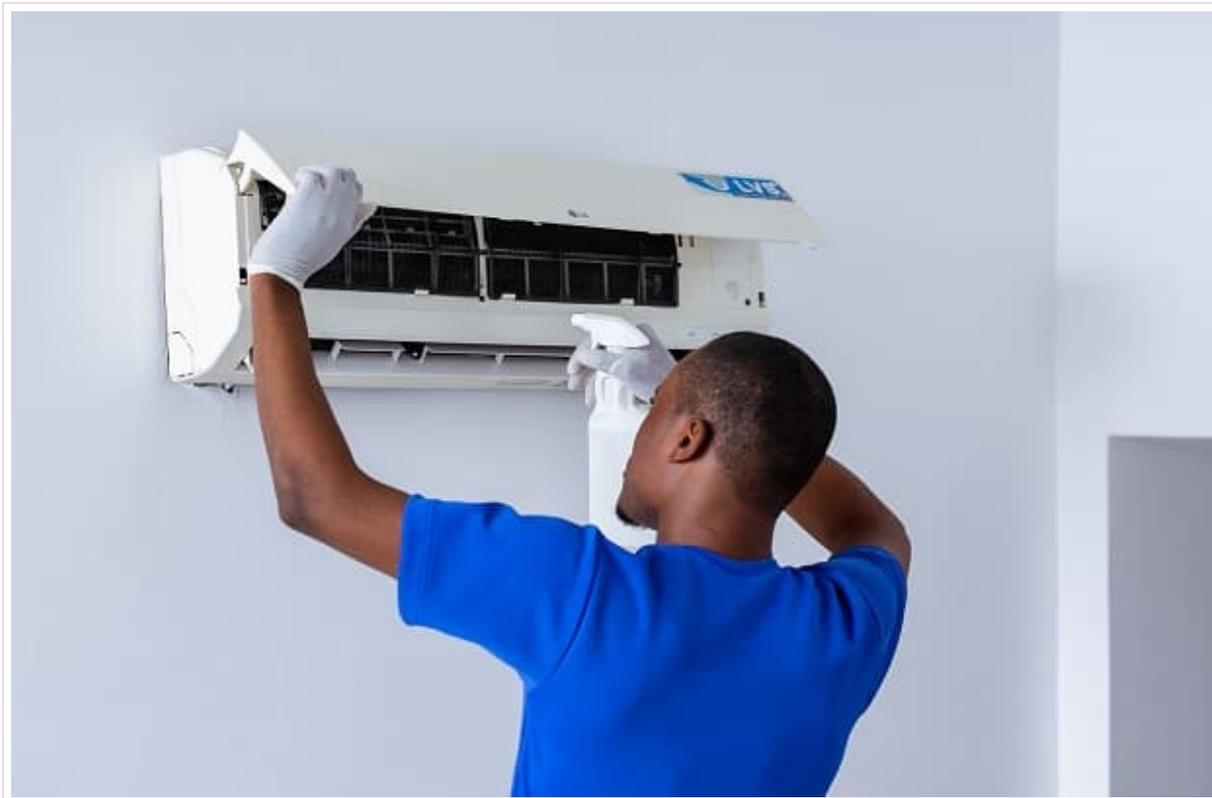
Vediamo ora **come pulire i filtri del condizionatore**. Dopo aver aperto il [climatizzatore](#) , bisognerà estrarre il filtro, che dovrà essere disinfettato, insieme alla batteria, sempre utilizzando il **sanificante per condizionatori** con potenza virucida. In questo modo, avremo igienizzato anche la parte interna del climatizzatore, completando così l'intera operazione di **sanificazione condizionatori**.
