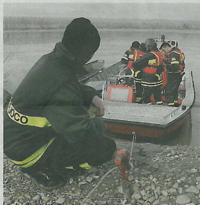
A Calendasco due dei 5 sbarramenti previsti per arginare l'onda nera ma il posizionamento dei "salsicciotti" si è rivelato difficoltoso. Sono stati necessari rinforzi con cavi d'acciaio (f. Petrarelli)
